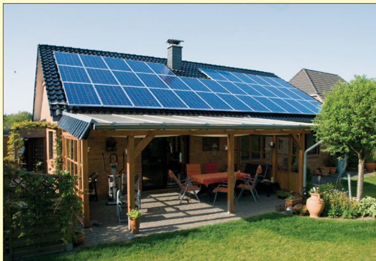
Obr. 2. FV panely na střeše rodinného domu
