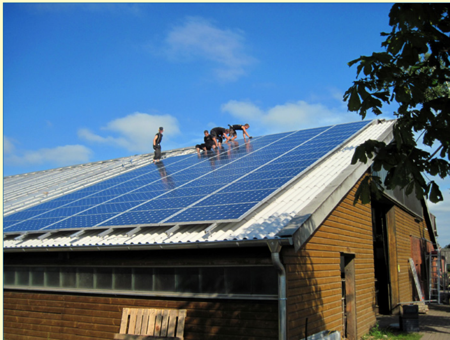
Obr. 1. Montáž FV panelů
