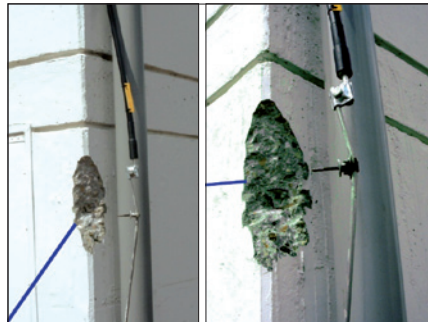
Obr. 2. Úder blesku do stanice mobilního operátora na síle dřevní štěpky, přechod vodiče HVI na holý vodič [1]
