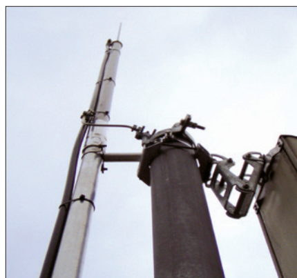
Obr. 5. Stanice mobilních operátorů; izolovaný hromosvod vodič HVI [1]
