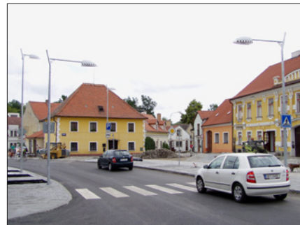
Obr. 8. Třeboň, třída Svobody – komunikační osvětlení Hellux NRS 115, včetně osvětlení přechodů pro pěší
