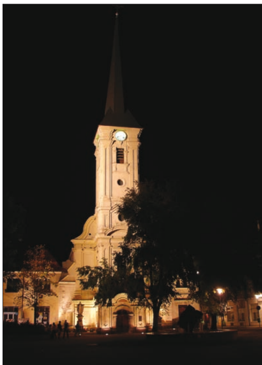
Obr. 3. Katolícky kostol Celkové osvetlenie kostola je zabezpečené výbojkovými svietidlami DecoFlood a DecoScene a je navrhnuté tak, aby neoslňovalo a nerušilo obyvateľov bývajúcich v okolí kostola; vstupná časť kostola a príľahlé časti sú osvetlené svietidlami DecoScene zabudovanými do zeme; celková rovnomernosť osvetlenia fasády sa dosiahla osvetlením bočnej a zadnej časti kostola svietidlami s asymetrickou krivkou svietivosti DecoScene
