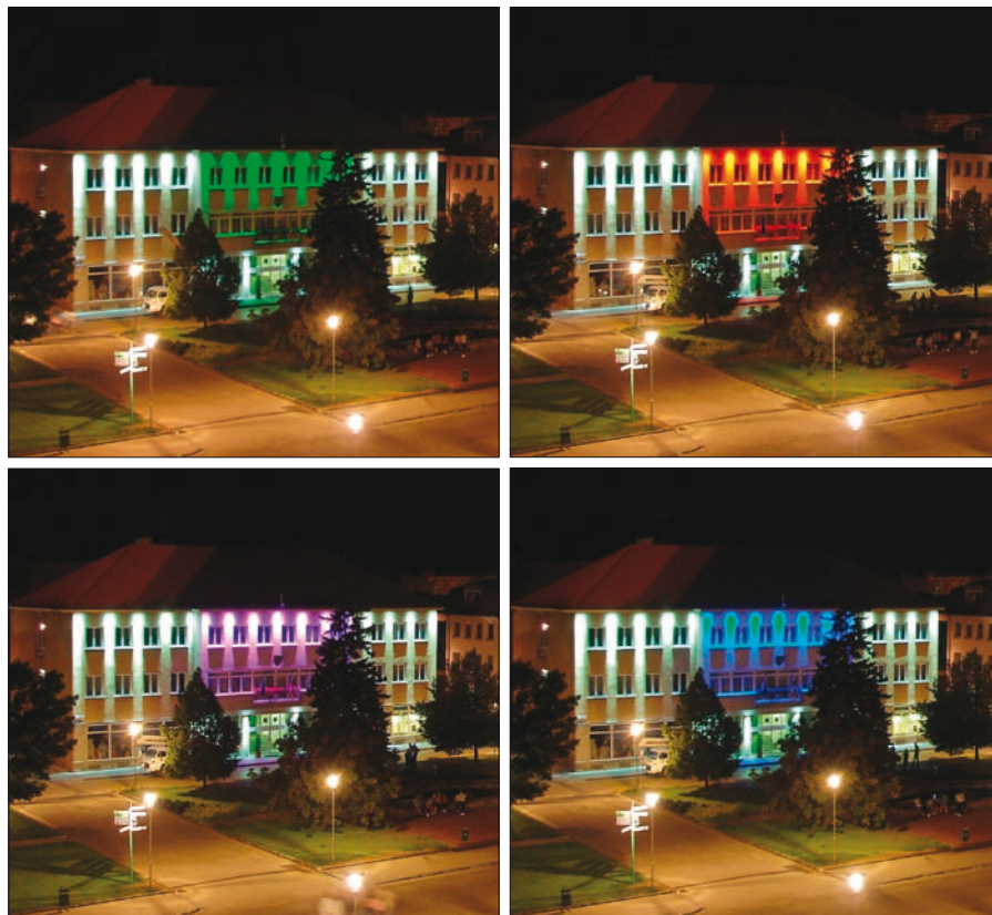
Obr. 6. Mestský úrad Fasáda budovy mestského úradu je rovnomerne osvetlená svietidlami typu LEDline 2 prisadenými na fasáde; obsahujú vysokovýkonné LED so špeciálnou optikou, ktorá zamedzuje oslneniu v neželaných smeroch a zároveň zvýrazňuje niektoré významné prvky na fasáde; po bokoch sa využila monochromatická verzia (biela farba svetla) a v centre sú použité svietidlá RGB, umožňujúce na fasáde hru farieb podľa naprogramovaných sekvencií; fasáda budovy mestského úradu tak získala nové ošatenie a stala sa novým výrazným prvkom námestia
