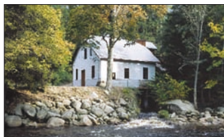
Malá vodní elektrárna Čeňkova pila
