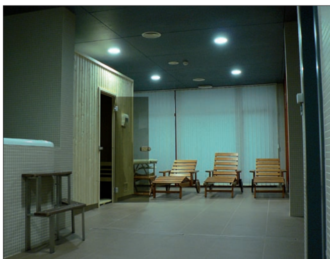
Obr. 10. Osvětlení hotelového wellness centra – zapuštěná svítidla Targetti CCT Flash
