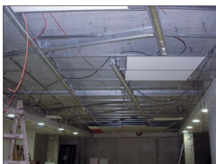
Obr. 9. Kongresový sál ve fázi realizace stropního osvětlení
