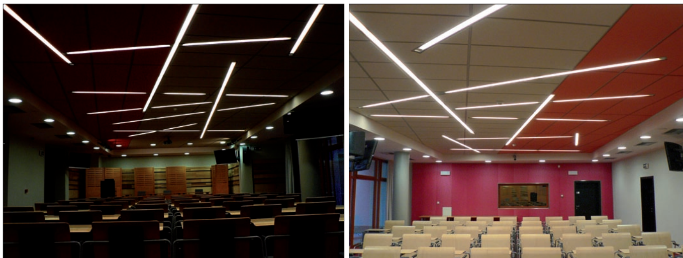
Obr. 8. Kongresový sál – atypické provedení sestavy Intra Linea DIM, pódium – reflektorová svítidla Targetti Foho Pro (vlevo – ztlumené osvětlení, vpravo – netlumené osvětlení)
