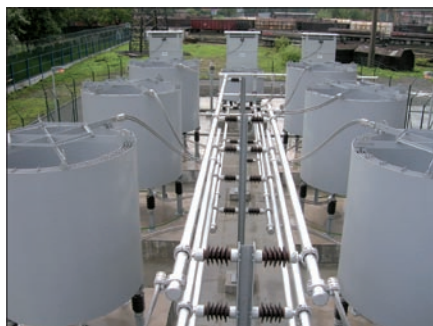
Obr. 3. Tlumivky dekompenzačního členu
