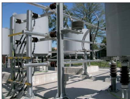
Obr. 6. Detail napojení venkovní části FKZ
