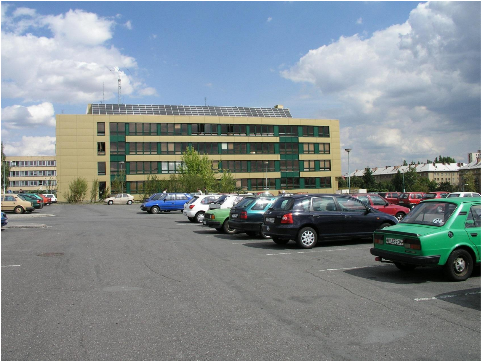
Obr.1 FV elektrárna VŠB-TUO (2001).
