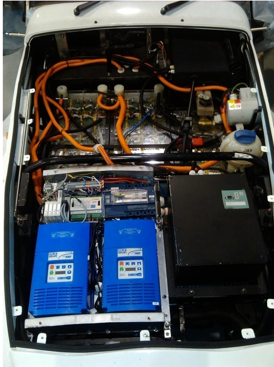
Zástavba integrovaného nabíjecího systému do 120A (parametrizace Siemens SIMOREG, zastavěno v prototypu K2, 2011)
