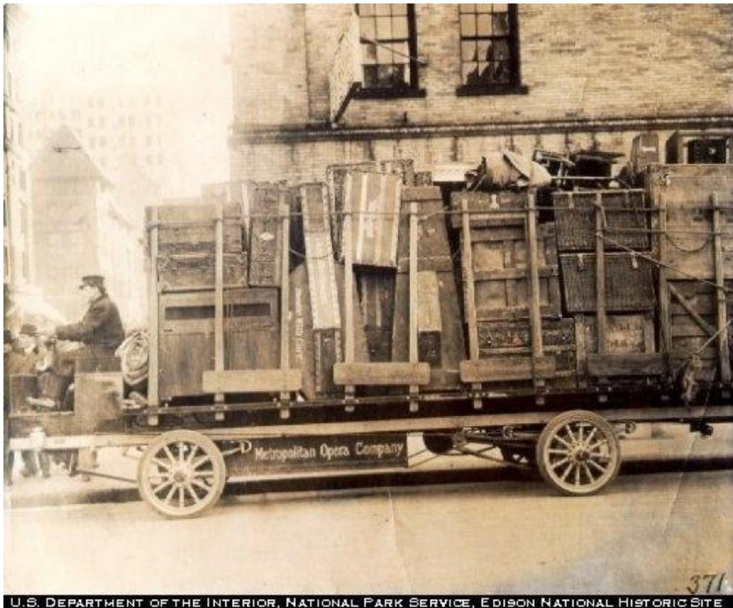
Obr. 13f Nákladní vozidlo MEC vybavené bateriemi Edison.
