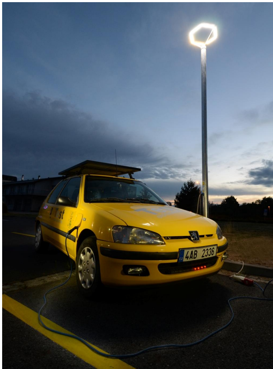
Obr.9 Nabíjecí stanice integrována do sloupu VO (2015).
